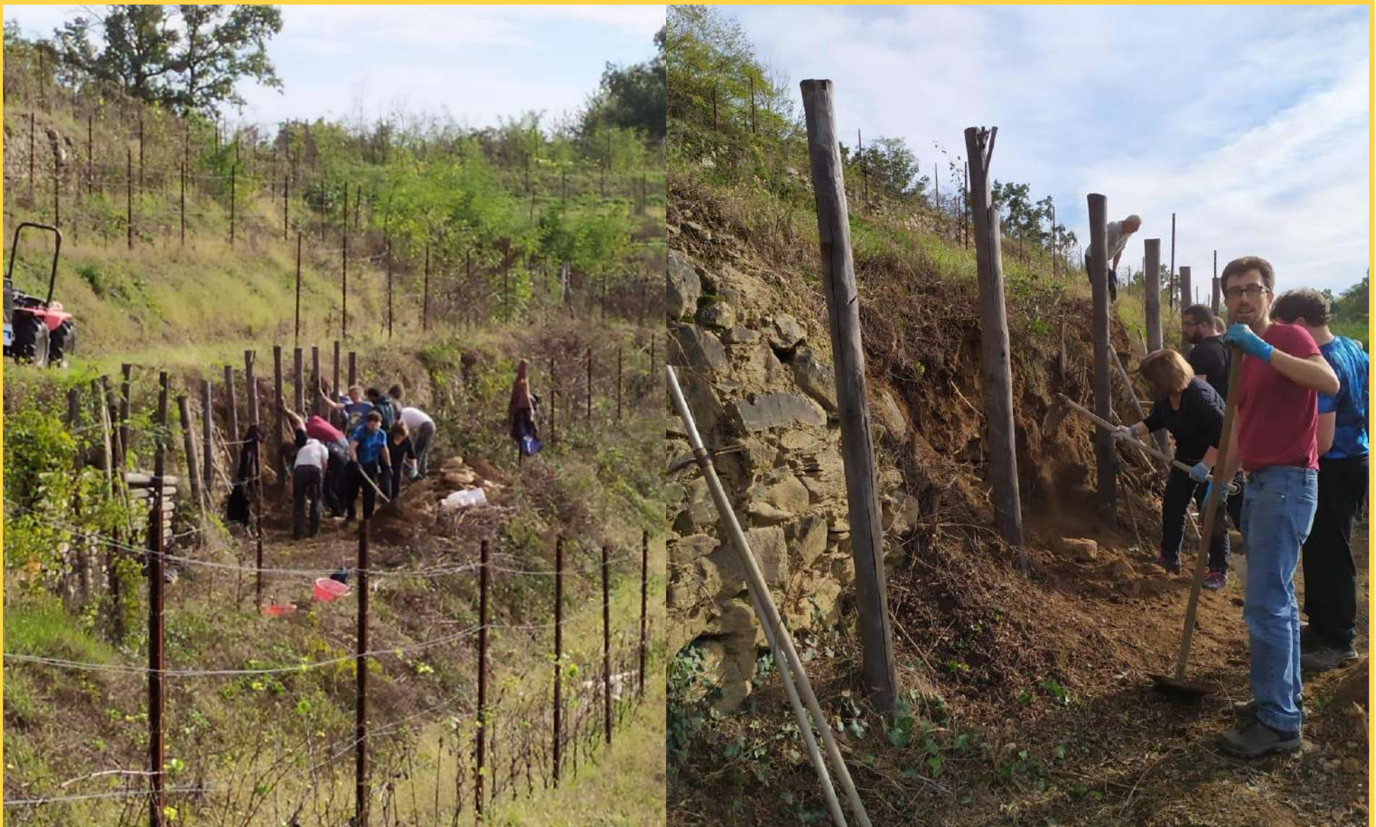
RECUPERO DEI TERRAZZAMENTI A SALUSSOLA
