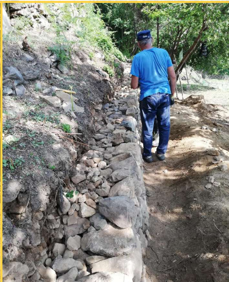
POSA DEL 5° E 6° CORSO DI PIETRE PARTICOLARE DEL DRENAGGIO
