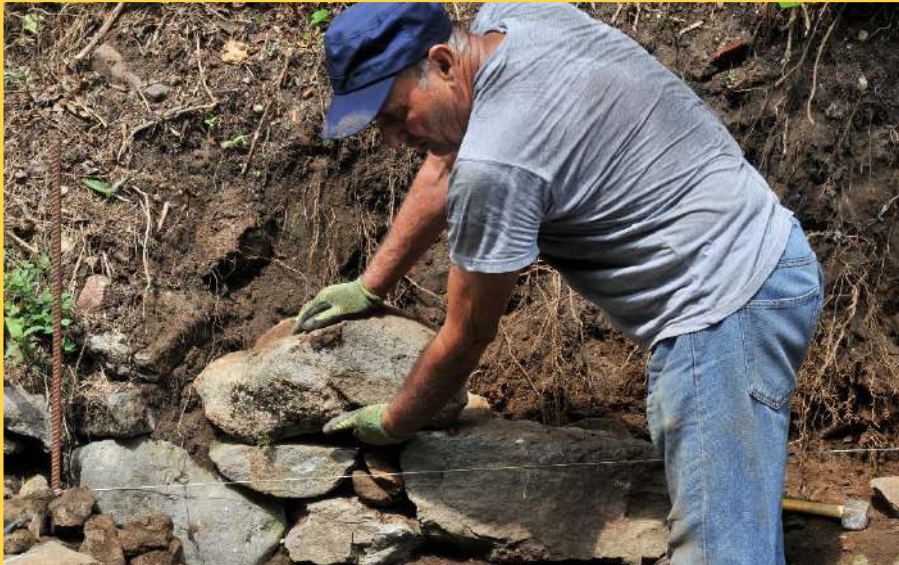
RICOSTRUZIONE DI UN MURO SU STARDA VICINALE CASALE TERRICO - CHIAVERANO
