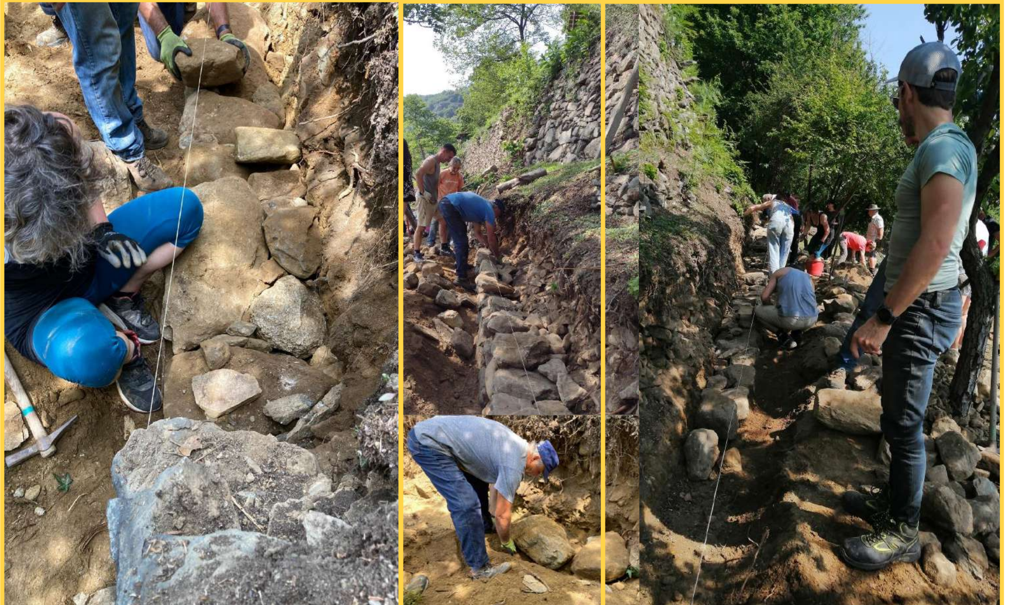
POSA DELLE PRIME PIETRE DELLA FONDAZIONE
